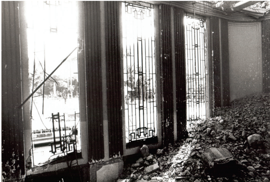
Figura 3. Processo de demolição do Cinema São Luiz, 1980
