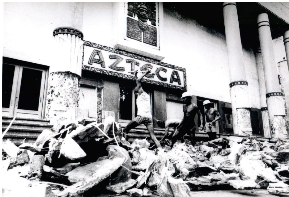
Figura 5. Derrubada do Cine Azteca
