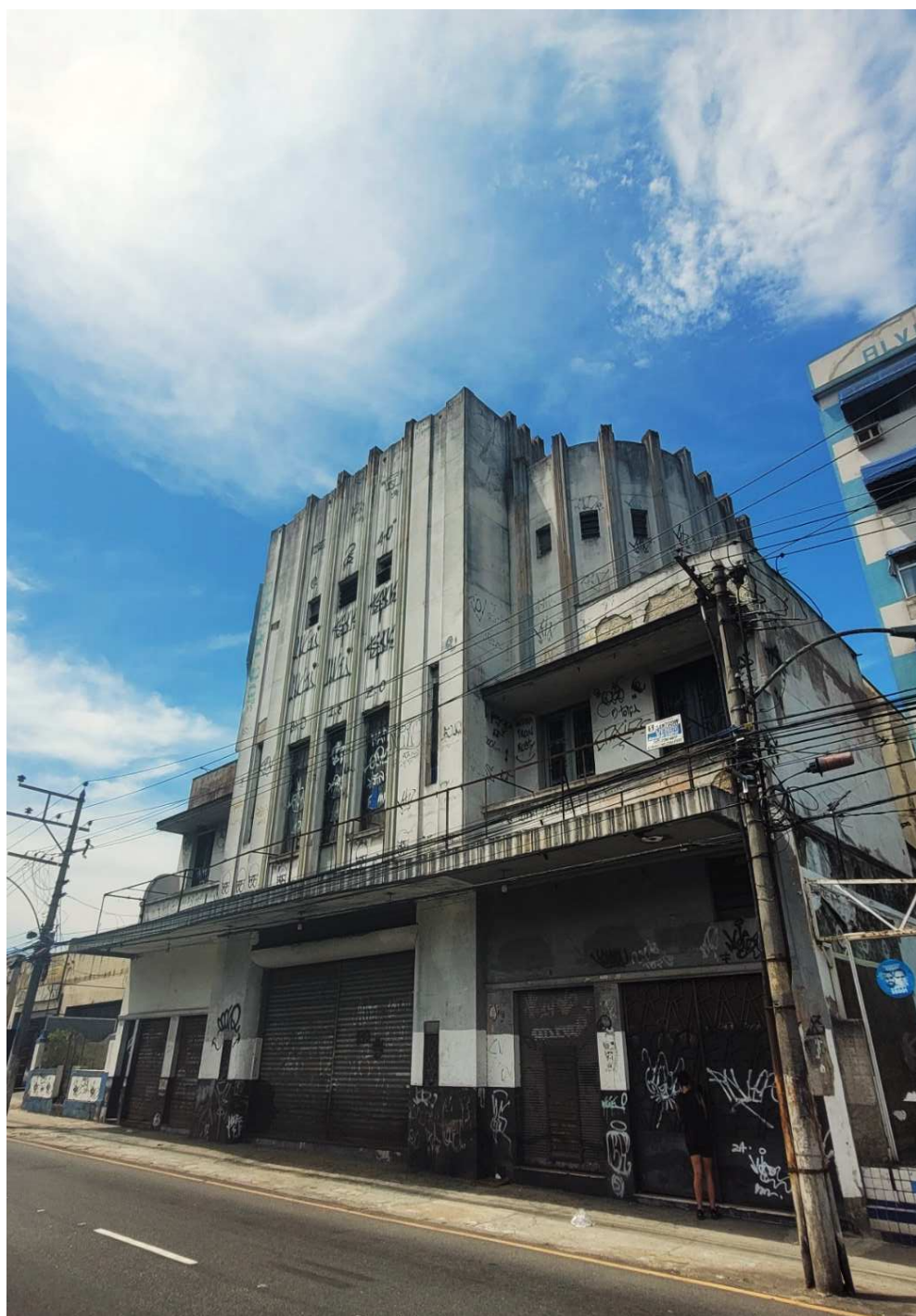
Figura 2: Fachada art déco das ruínas do antigo Cine Rosário/Cine Ramos , situado no bairro de Ramos. Fonte: Pesquisa de campo (2025).
